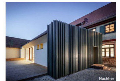
Abbildung 18: Umnutzung eines ehemaligen Rathauses (Quelle: Gesine Schmidt und Klaus Heim)
