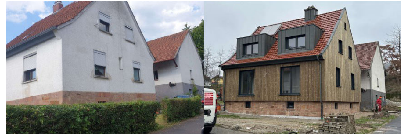
Abbildung 17: Sanierung eines Wohnhauses - Vorher und Nachher (Quelle: Gesine Schmidt und Klaus Heim)
