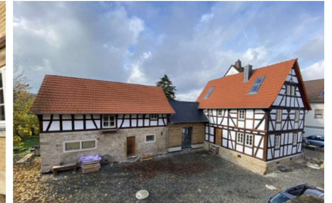
Abbildung 11: Die Hofreite nach der Sanierung (Quelle: Gesine Schmidt und Klaus Heim)
